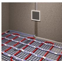
8. **Установите терморегулятор** (при отключенном сетевом напряжении!) согласно прилагающейся к нему инструкции. **Терморегулятор должен быть настроен на работу строго по датчику пола!**
